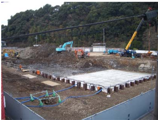
A工区 捨てコン作業 (平成28年2月1日)
