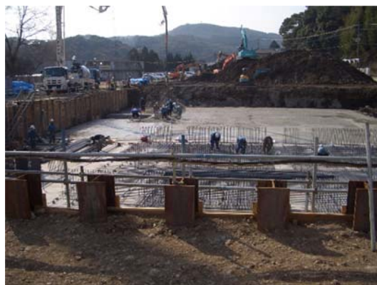
A工区 配筋作業 (平成28年2月4日)
