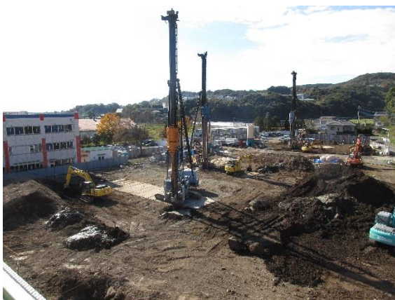
改良杭工事（平成27年12月）
