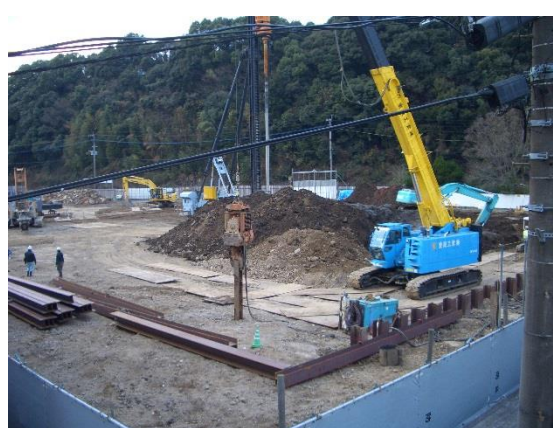
山留親杭打設工事（平成28年1月）
